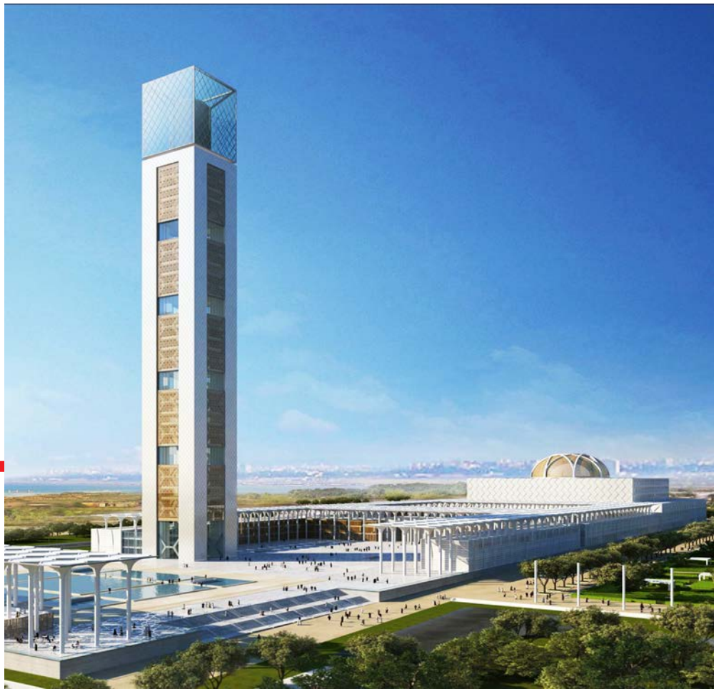
十一月。世界最高的大清真寺宣礼塔——265米高的阿尔及利亚大清真寺宣礼塔工程地下室基础全部完成。中国建筑承包,中建三局承建。
