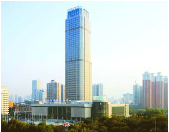
十二月。三晋第一高楼——208米的大太原湖滨广场国际会议中心交付使用。大楼地处太原市区中轴线。中建三局承建。
