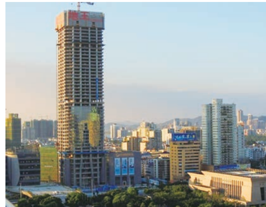
八月。“广西第一高楼”——柳州地王项目50F梁板浇筑完成,全面突破200米。中建五局承建。
