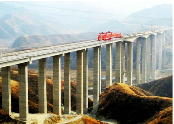
十一月。中国在建最高桥梁——五孟湾沱河特大桥连续钢构全部合龙。大桥全长1210米,8个主墩高度均在100米以上,为华北第一高。中建七局承建。
