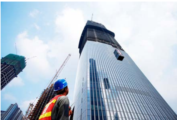
九月。广州在建第一高楼——广州东塔项目外框标高突破300米。广州东塔是世界上唯一采用双层钢板剪力墙核心筒与钢结构外框组合结构形式的超高层建筑。中国建筑股份有限公司承建,中建四局、中建三局组建管理团队实施,中建钢构负责钢结构施工。
