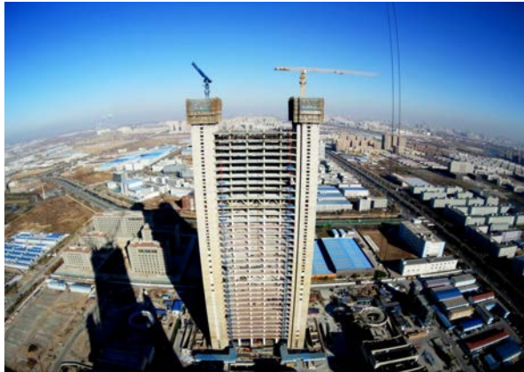
八月。中国在建结构第一高楼——天津117大厦主塔楼结构标高突破百米大关。工程地上117层,高597米,总建筑面积84.7万平方米,创民用建筑单体面积之最。中建三局总承包公司承建,中建钢构负责钢结构施工。
