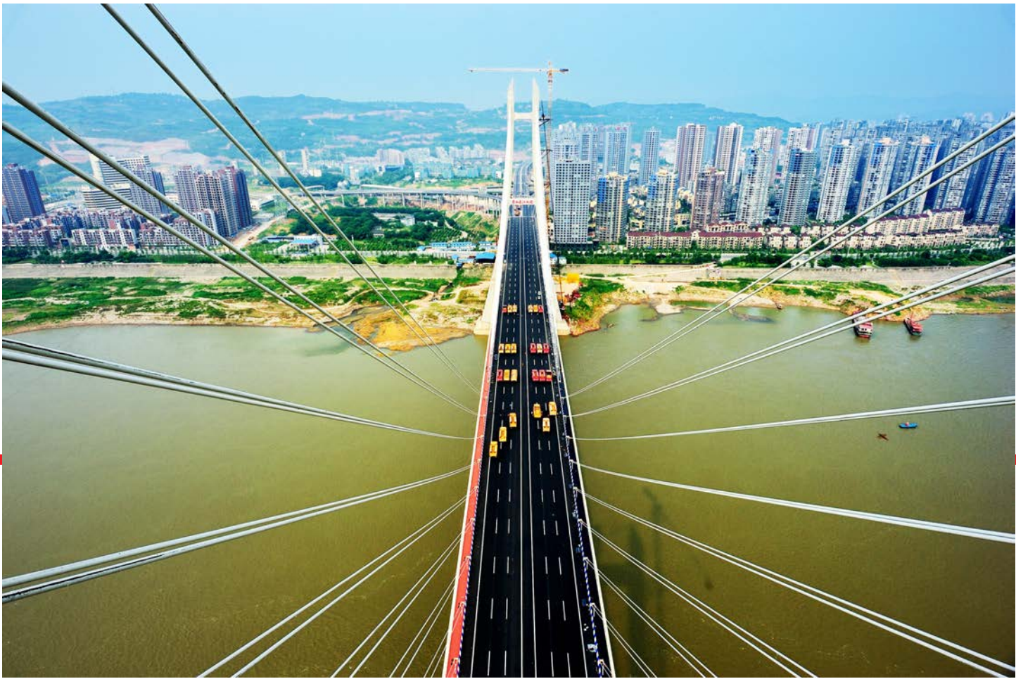
六月。长江上游第一座公轨两用钢桁梁斜拉桥,中国建筑承建的第一座长江大桥——重庆鼎山长江大桥斜拉桥顺利通车。大桥全长6066米。中国建筑承建,中建六局施工。
