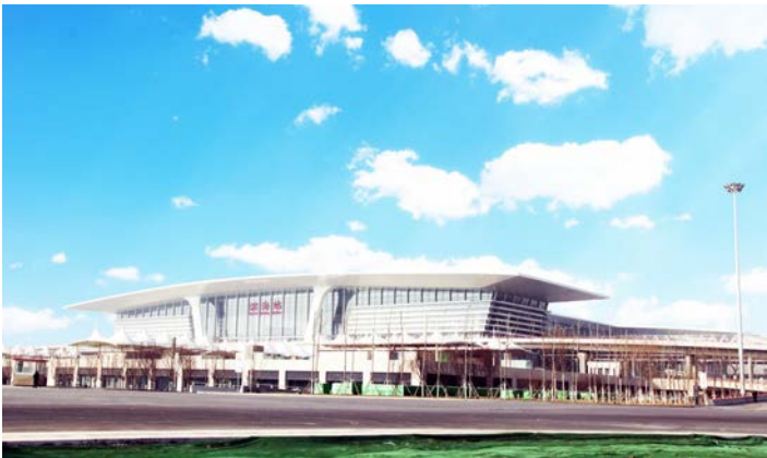
十二月。天津至秦皇岛高速铁路沿线最大高铁站——津秦客专滨海站投入使用。中国建筑承建。
