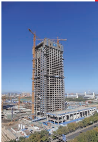
10月10日,由中建三局北京公司承建的北京中国建筑大厦主体结构封顶,建成后将成为中建总公司总部大楼。 (黄凯 罗仁仲)
