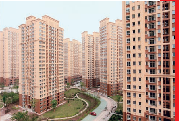
五月。全国最大规模的公租房项目——重庆市城南家园竣工验收。总建筑面积211万平方米。中建七局承建。
