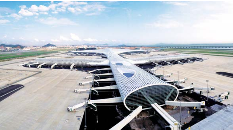
十一月。深圳最大公用建筑——深圳机场T3航站楼投入使用。中国建筑股份有限公司承建,中建三局、中建八局分两个标段实施总承包管理,中建钢构负责钢结构工程深化设计、制作、安装。
