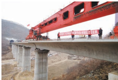
截至12月10日,中国建筑沈阳项目提前超额完成全年施工任务,凤城制梁场281孔箱梁架设任务圆满完成。 (黄启钊)
