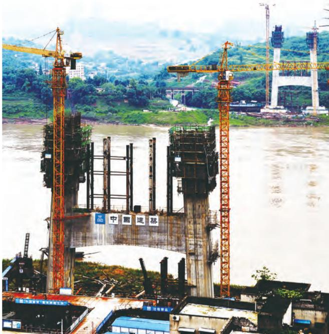
近日，中建六局承建的中国建筑首座跨主河流域悬索桥梁——重庆几江长江大桥南塔施工突破60米，北塔施工突破50米，均超过了塔身高度一半。几江长江大桥全长1897米，主跨600米双索面一跨过江，是迄今为止中国建筑承建的主跨最大的桥梁。（赵蔚生/摄影报道）
