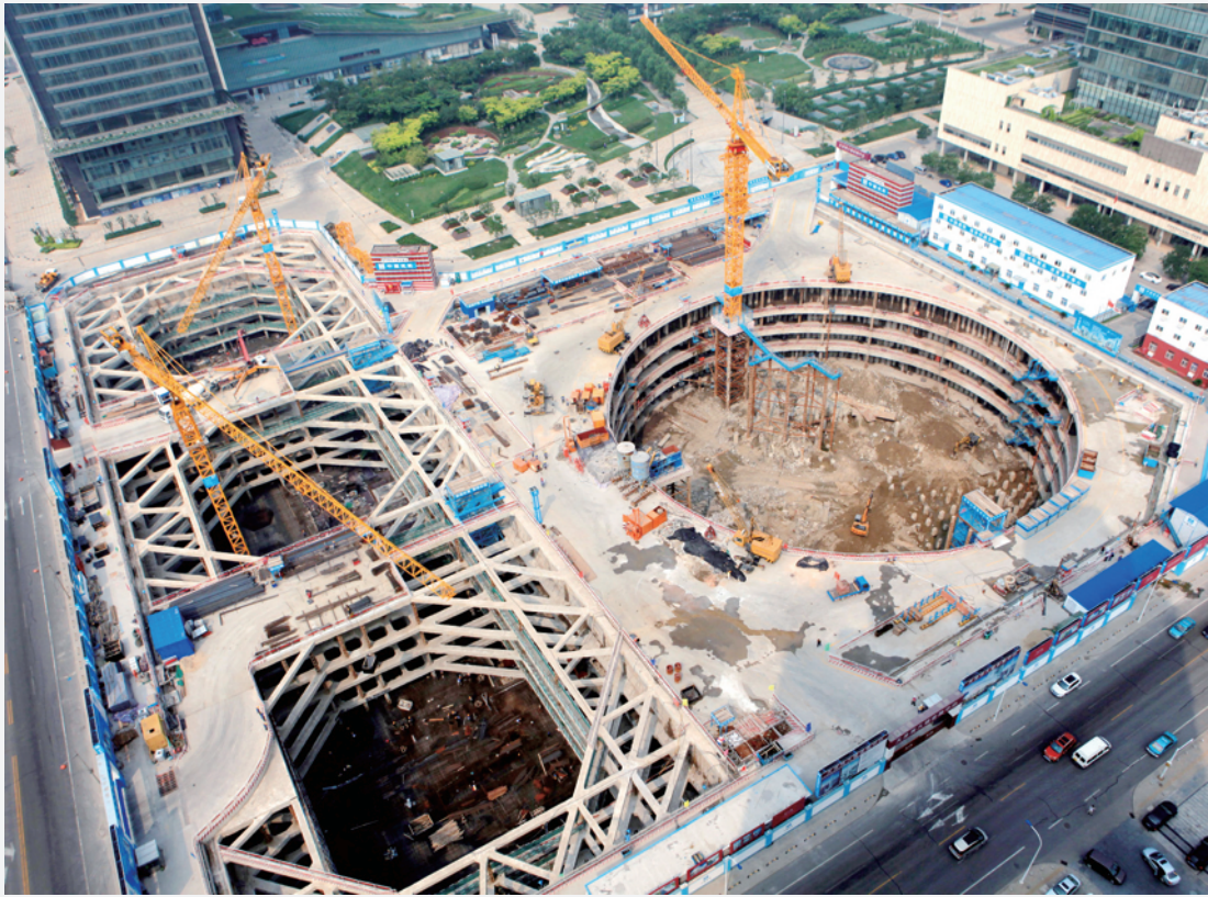
近日,中建八局承建的天津周大福金融中心项目工程正式进入主体结构施工阶段。目前,该项目已完成裙房部分基础底板施工,深32米的塔楼基坑开挖接近尾声。(李双凤/摄影报道)
