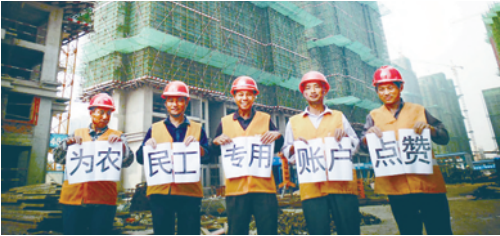
近日,中建三局一公司华东公司合肥橡树湾项目部为近一百位农民工兄弟办理了工资卡,大家对此纷纷点赞。(上官元猛)
