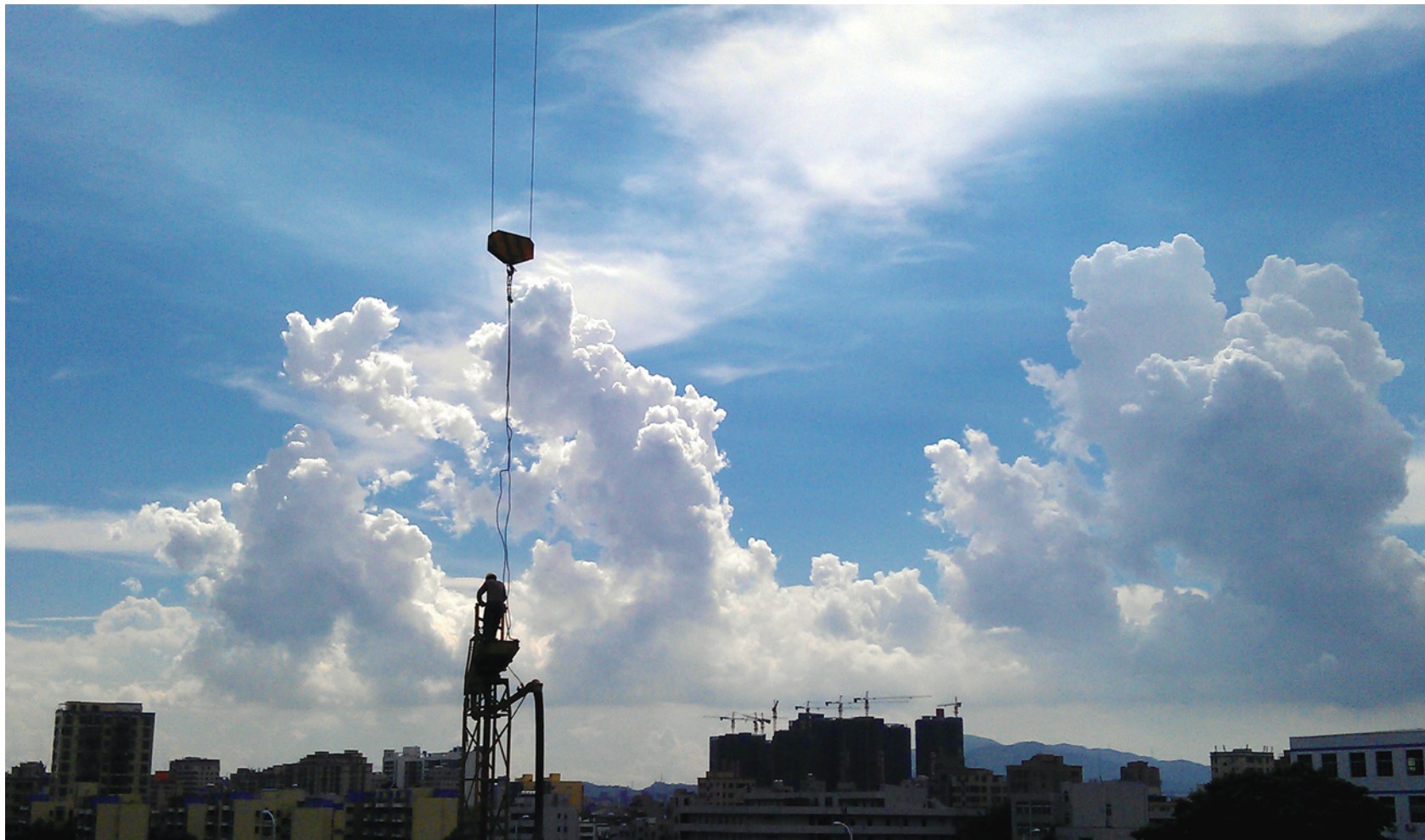
《穹顶之下》——中建五局工业设备安装公司 陈伟
