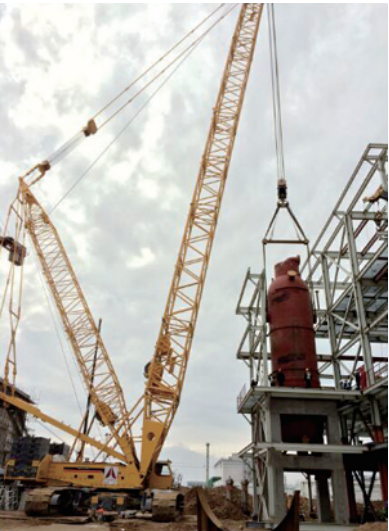
近日，中建新疆安装公司新业项目部经过精心准备，完成了单体最重设备——高17.86米、直径3.6米、重量达235吨的合成塔吊装。
