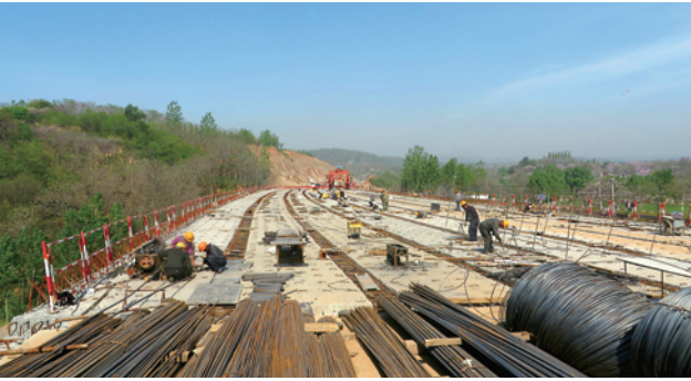
近日，随着黑水河大桥最后一片预应力钢筋混凝土箱梁吊装就位，中建七局交通公司担负施工的总长26.37公里的河南省道323线一、二标全线率先贯通。
