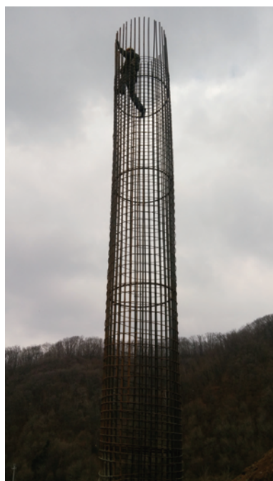
《桥工 style》——中建六局桥梁公司 徐向东
