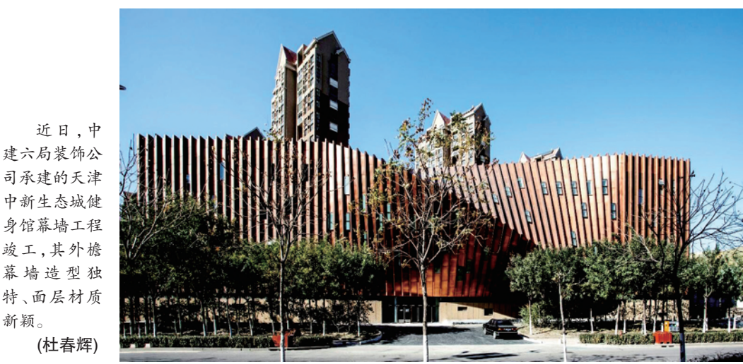
近日，中建六局装饰公司承建的天津中新生态城健身馆幕墙工程竣工，其外檐幕墙造型独特、面层材质新颖。（杜春辉）
