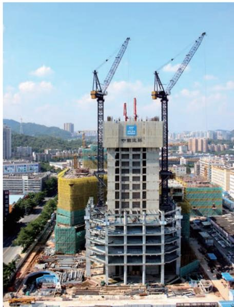
近日,中建二局三公司项目部应用液压爬模、铝合金模板、动臂塔吊爬升等10余项新技术承建的深圳深业物流中心塔楼核心筒高度达到了100.45米。该项目设计高度317.6米,建成后将成为一站式国际高端物流交易超高层城市综合体。(郭朋朋 施振源)
