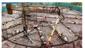
个头、强度符合要求的废混凝土块被填充在裙楼梁板钢筋网中,等待浇筑。
