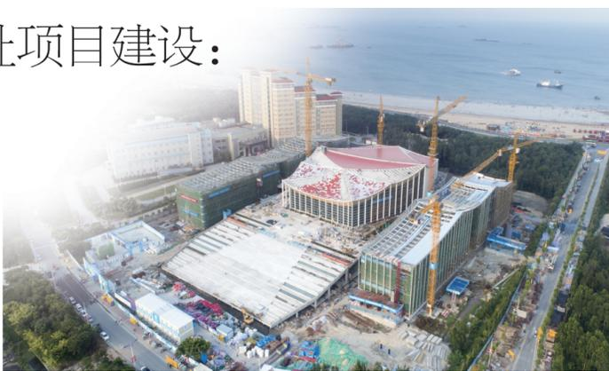
10天，项目完成1219根预应力管桩施工，创造了中建海峡有史以来管桩施工的最快速度；30天，项目完成5000吨钢结构安装；30天，项目完成主楼一层西侧幕墙设计及安装，刷新了中建海峡幕墙施工速度纪录；3个月完成主会场两万平方米的高标准室内精装以及复杂综合体的安装。
