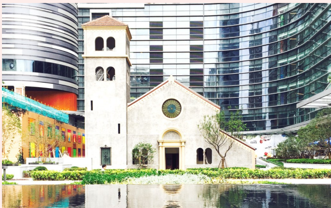
中建一局承建的上海长宁来福士项目竣工完美修缮圣玛利亚女中旧址
