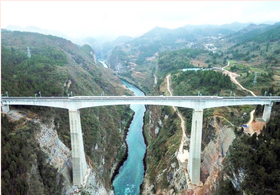
中国建筑参建的渝贵铁路开通运营
