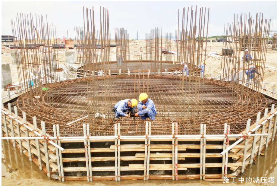
施工中的减压塔
