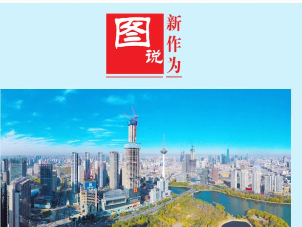
近日,中建铁投东北公司承建的沈阳宝能环球金融中心T2塔楼核心筒封顶,主体结构高度达308米,超过305.5米高的辽宁广播电视台,成为东北第二高楼。沈阳宝能环球金融中心由7栋超高层塔楼组成,总建筑面积106万平方米,是集豪华住宅、精品商业、酒店公寓及高端写字楼于一体的都市综合体。(刘佳吉、洪旭)
