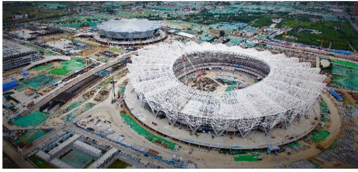
建设中的西安奥体中心
