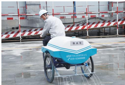
本报讯(通讯员李竺君)日前,中建二局二公司锦尚中心项目上演了扬尘治理“全武行”:在工地大门、绿化带以及工程主体的安全网上,都安装了先进的喷淋设施,进出车辆、草坪、安全网架被定时喷淋。当水源开关打开的一瞬间,地下绿化带、空中大楼架体上,几十个喷水龙头一起发射,只见水花飞舞,状如喷泉,非常漂亮。
