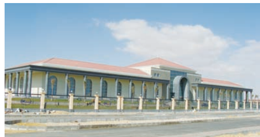
中建八局天津公司承建的中国援助埃及苏伊士湾西北经济区投资服务大楼交接仪式于近日举行，埃及总理甘迪勒为大楼揭牌。（孟超）
