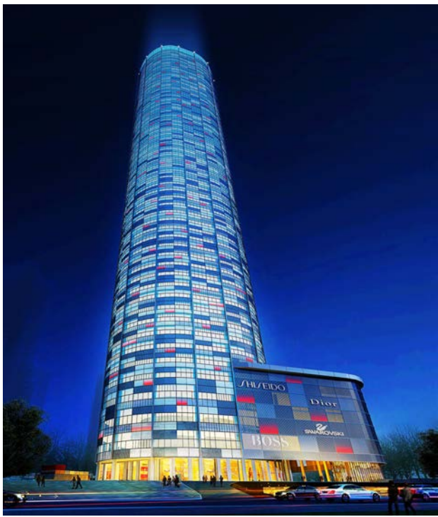
近日,中建钢构华东大区中标青岛第一高楼——青岛国际航运中心钢结构工程,工程高度254.4米,钢结构吨位约1万吨。(刘清泉 全勃翰)
