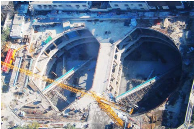
近日,中建一局天津金融街(和平)中心工程项目部,精心组织、昼夜奋战,顺利完成1#楼总量约为13400立方米基础底板混凝土浇筑。该项目是继天津环球金融中心(津塔)之后,天津市中心又一较大工程,位于天津最大步行街——滨江道商业圈。(王俊光)
