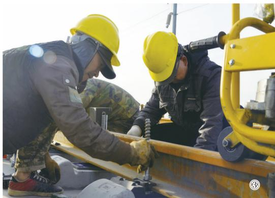
图③:白天,施工人员对夜间测量标注点精心调整
