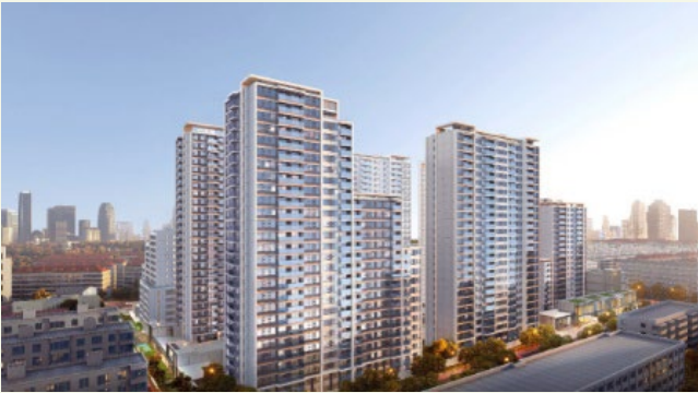
上海楊浦超低能耗建築項目
