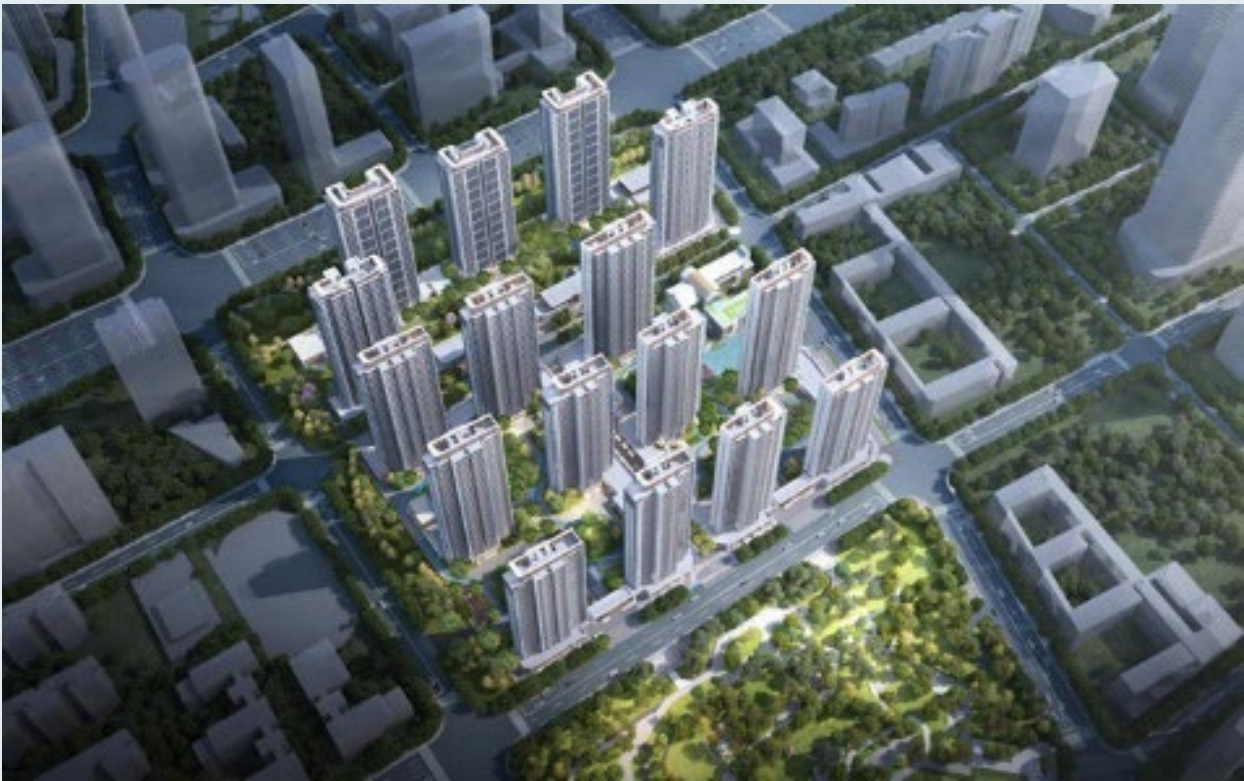
廈門泥窟石村片區安置房
