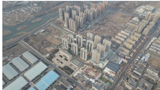
翠湖溪岸項目施工
