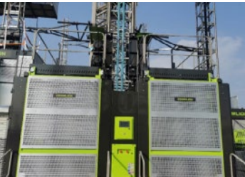
無人駕駛施工電梯
