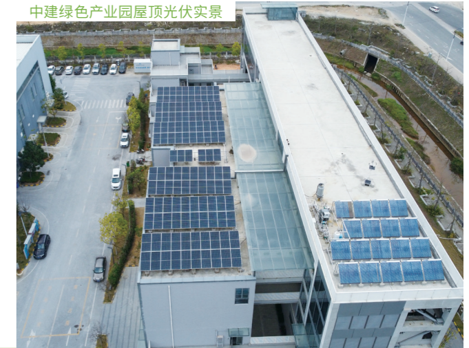
中建绿色产业园屋顶光伏实景
