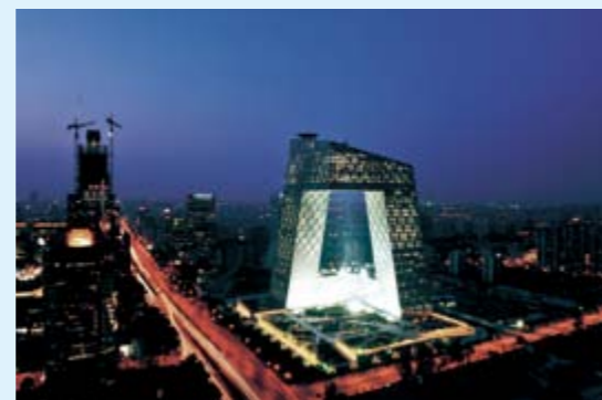
中央电视台新台址主楼项目 New CCTV Tower
