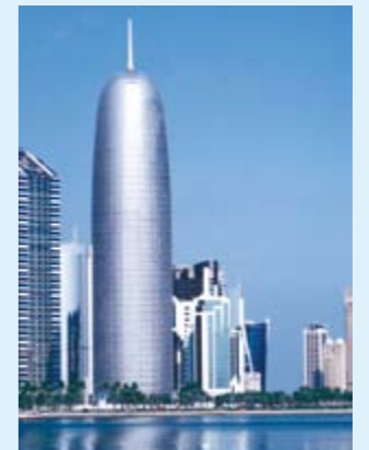
卡塔尔多哈高层办公楼项目 Doha high-rise office building project
