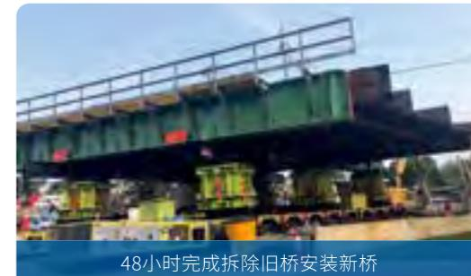
48小时完成拆除旧桥安装新桥
