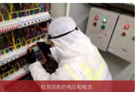
检测风机的电压和电流
