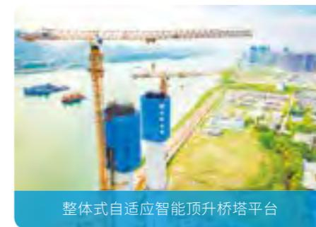
整体式自适应智能顶升桥塔平台
