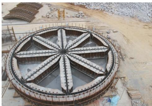
近日,在中建建筑港承建的大连泛海旅游度假区项目,用于码头建设的3400吨圆形沉箱完成预制,并将由公司6000吨半潜驳1船托运到指定位置安装。该沉箱直径22米,高19.7米,重3445吨,是中国建筑承建的最大圆形沉箱。(丁超)
