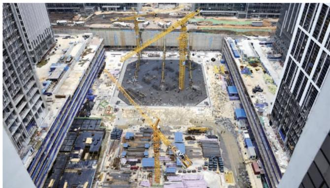
近日,中建八局一公司施工的济南汉峪金谷A5地块项目采用“深基坑溜管法大体积混凝土快速布料技术”,历时19小时36分钟,完成1.1万立方米混凝土基坑浇筑,5分钟浇筑320立方米,创造了国内混凝土瞬时浇筑速度新纪录。(赵生智 王立军)
