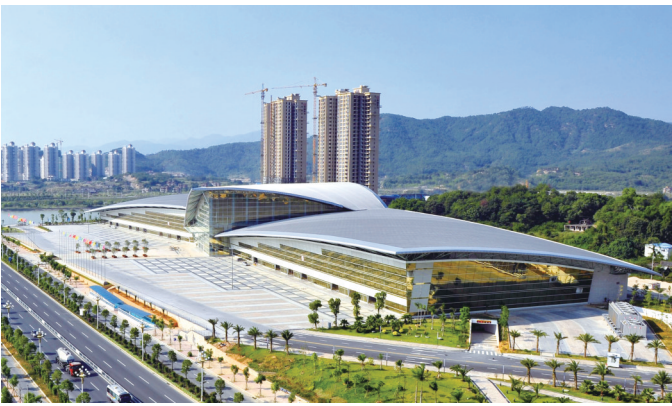
鲁班奖工程——福建成功国际会展中心
