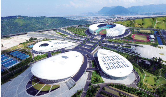
鲁班奖工程——福州海峡奥林匹克体育中心
