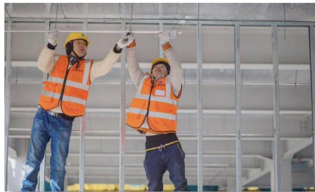
室内装修工人安装吊杆
