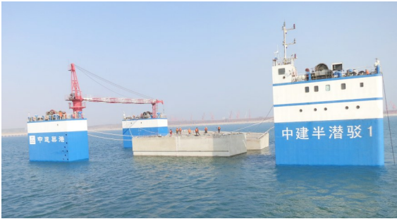
“中建半潜驳1”一次拖带两个沉箱
