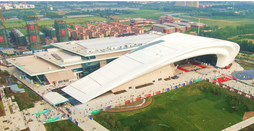
该工程由中建钢构EPC总承包承建,中建三局、中建五局、中建八局参建。(吴梦然/摄)
