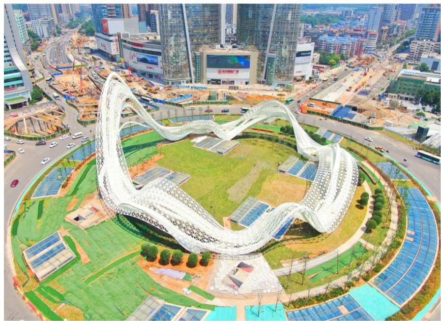
近日,中建钢构履约的国内最大单体大型钢结构公共艺术品——武汉光谷广场综合体“星河”雕塑完成主体施工,并开始进行灯光调试。“星河”雕塑采用全钢结构制造,中建钢构负责主龙骨钢结构施工,“骨架”由7根龙骨组成,雕塑最大高度41米,相当于13层楼高,直径90米,单拱最大跨度36米,建成后将成为武汉市城市新地标。(安晨宇)
