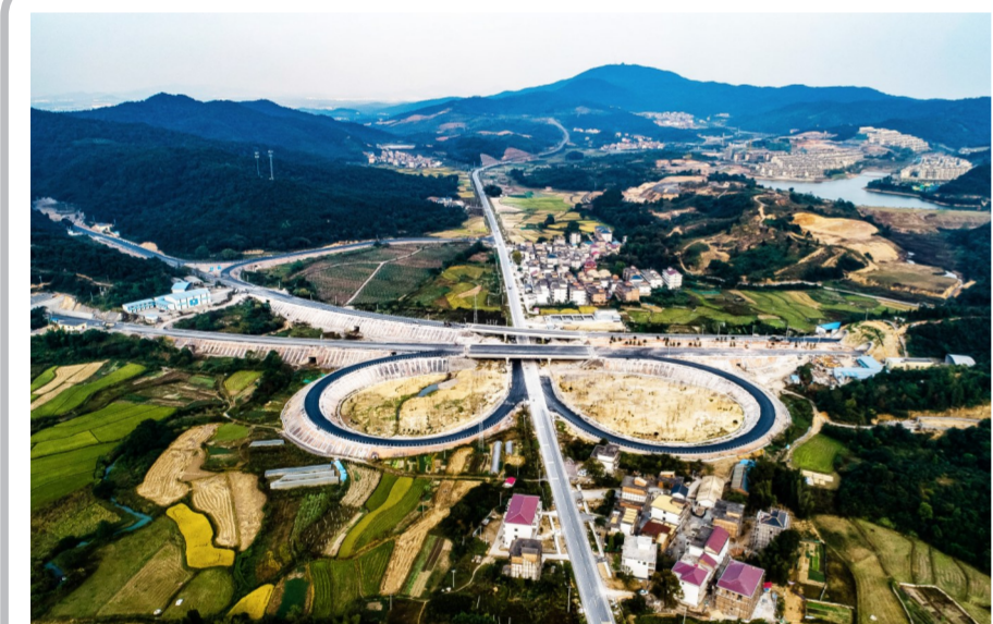
11月9日，中建市政公司履约的江西新余环城路项目大桥至仰天岗大道全面建成通车。道路全长25公里，包括高架桥、跨沪昆高速桥、跨河大桥、隧道等。（张贝）
