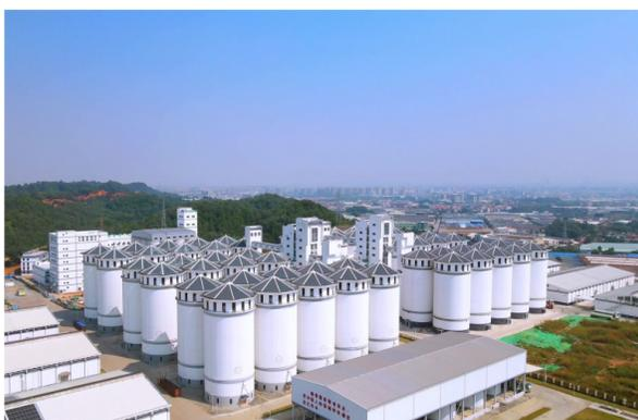
近日,中建四局承建的广东佛山粮食仓储设施及小麦应急加工生产线建设项目竣工。项目总用地面积约40.2亩,建设有3万吨立筒仓和2条小麦加工生产线及其附属设施。投产后小麦年加工能力达到18万吨,将进一步提升佛山市粮食储备和应急加工能力,对保障国家粮食安全、稳定粮食价格有重要意义。(邓家欣)
