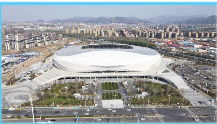
项目外立面应用航天技术产物——ETFE膜结构,透光性最高可达95%,0.25毫米厚的膜结构可完全承载一个人的站立重量,抵抗青岛百年不遇的大风,同时还具有均匀性强、自洁性好、抗老化、抗腐蚀、抗冲击、阻燃、可回收的优点。
