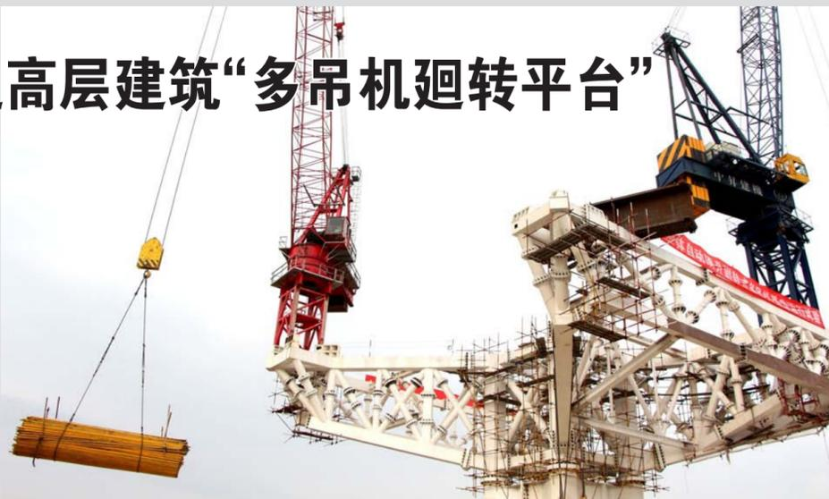
平台由支撑顶升系统、回转驱动系统、钢桁架平台系统和塔机组成。塔机置于回转平台系统上,依托平台回转驱动系统可进行360°圆周移位,实现塔机吊装范围对超高层建筑的360°全覆盖,并
