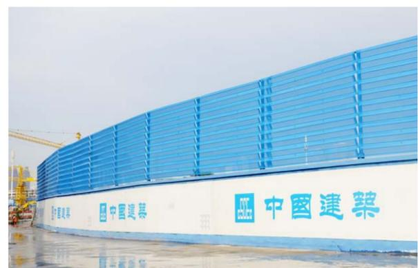
本报讯 (通讯员李琦岩 吴泽昊)近日,中建六局总部新址(中建中心)项目在天津市率先采用防风抑尘墙环保新设备,现场抑尘率达80%。该设备通过特制挡风板对风能产生不同尺度的分离漩涡和强烈的干扰气流,进而削弱风速,减少起尘率,实现良好抑尘效果。此外,该设备可重复使用,挡风板可灵活拆卸移动,节省了苫盖、围挡、地面硬化等费用。
