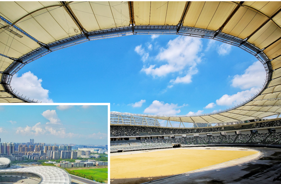
中建三局华东公司苏州工业园区体育中心项目国内最大跨度单层索网膜结构施工告竣
