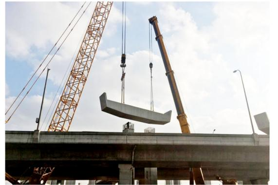
近日,中建土木公司承建的全国第一条全线路预制装配式高速公路(立柱、盖梁、箱梁、管涵等全预制)——上海S7项目PSN12起盖梁安装成功,标志着项目部取得了阶段性成果。(康琳 雷大喜)
