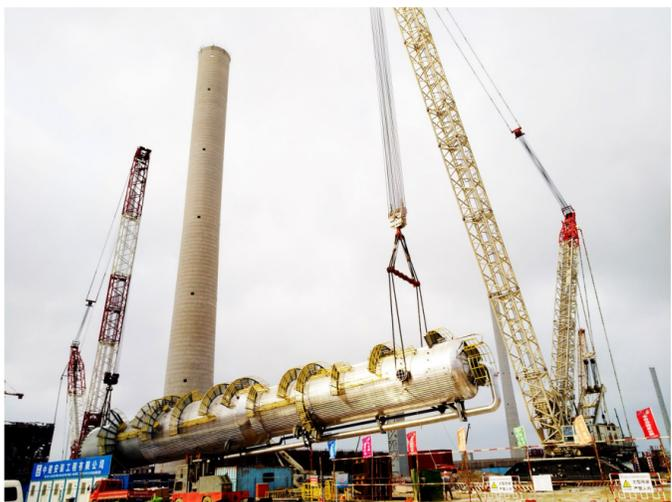
中建安装恒力石化项目混合脱氢装置首批核心设备吊装完成
