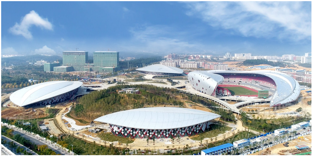
中建四局三公司贵州遵义奥体中心工程竣工
