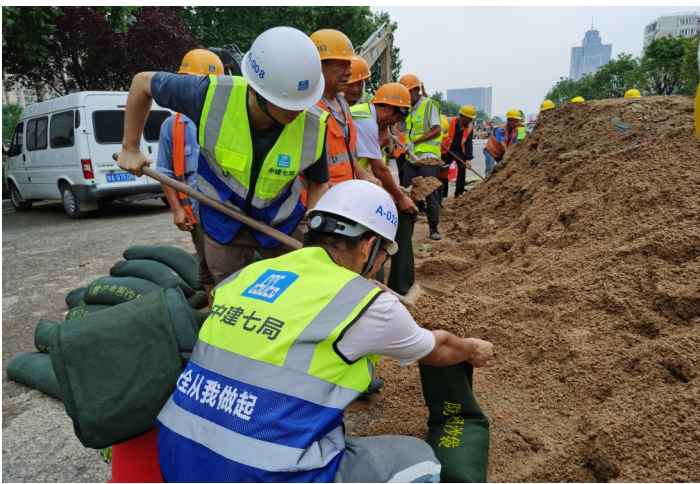
7月22日，中建七局交通公司集结130余人开赴郑州航海西路跨金水河桥塌方现场抢险，图为救援队到达后火速装填防汛沙袋。
