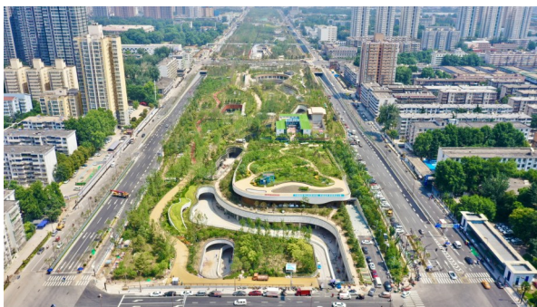
西安幸福林带建设工程
