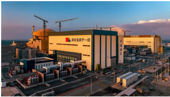
广西防城港核电站
