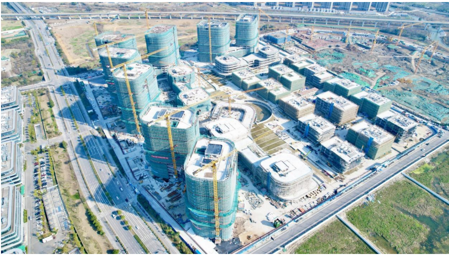
中建一局建设发展公司承建的杭州菜鸟西湖云谷产业园项目全面封顶,进入装修和幕墙施工阶段。项目总建筑面积约62万平方米,共计28栋单体建筑,施工过程中项目团队应用BIM5D技术,使用TEKLA软件进行钢构件分段深化、节点优化和方案模拟,并根据现场进度动态转化,提高施工精确度。项目建成后,将成为具有自主知识产权、掌握核心技术的智能化研发、生产及检测中心,助力中国云计算和大数据技术发源地及核心产业带建设。
