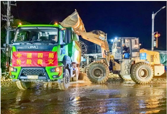
中建四局第一时间调拨大型机械设备投入抢险救灾
